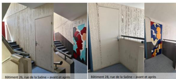
Bâtiment 26, rue de la Saône – avant et après
