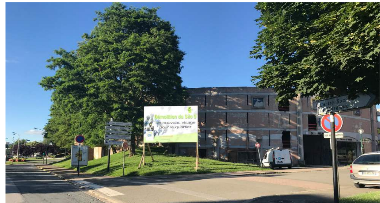
L'ancien parking silo 9 de Plaisir, démoli en 2019
