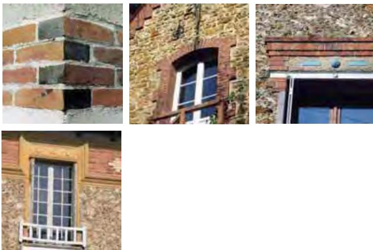
**La brique** existe par petites touches sur les constructions rurales et de bourgs où elle est utilisée pour les souches de cheminée et quelques encadrements d'ouverture.
