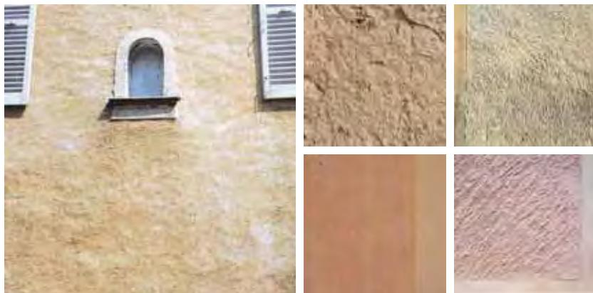
**Les enduits couvrants** masquent les pierres des murs et sont associés à des modénatures\* qui soulignent la composition de la façade et jouent un rôle technique.
