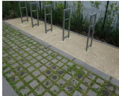
Principe de revêtement perméable
