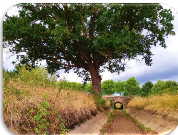
Rigole maçonnée, à l'ouest du Val Favry
