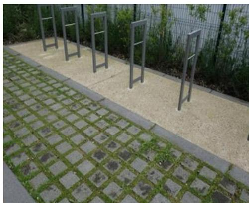
Principe de revêtement perméable
