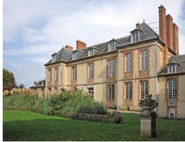
Le château de Plaisir avant sa restauration
